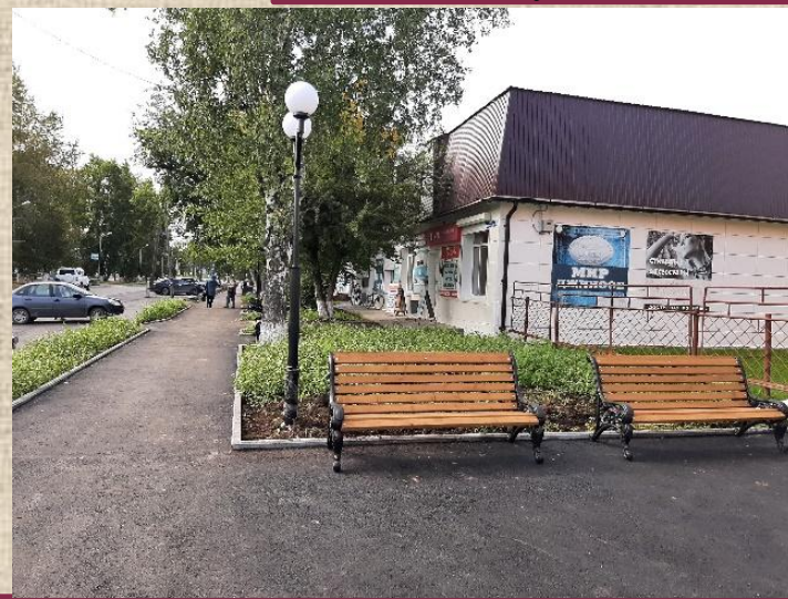
Благоустройство тротуара по ул. Белинского (от ул. Кирова до ул. Ленина)
