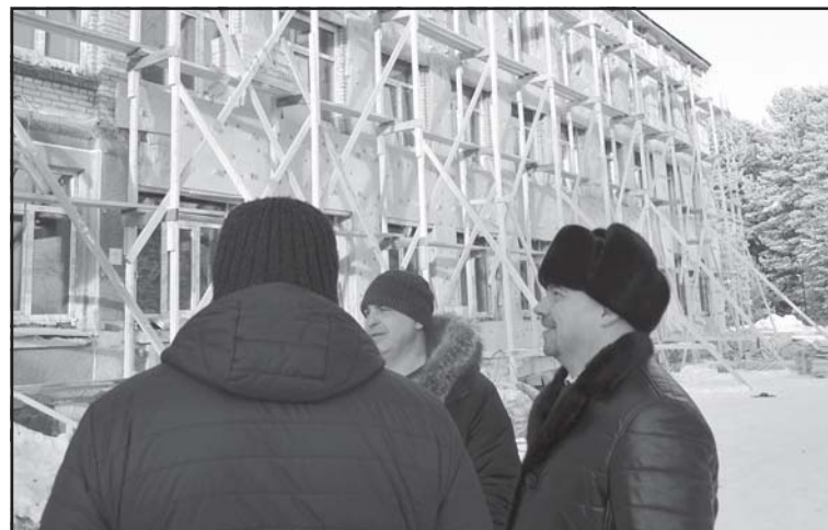
Ведутся работы на фасаде здания СОШ №2
