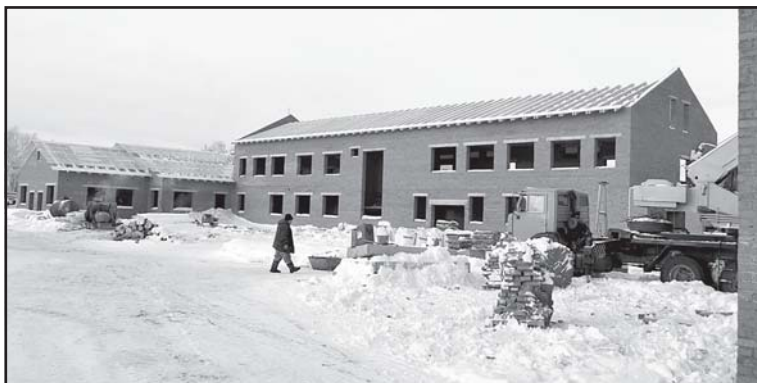
Здание Саровской школы поражает своими масштабами и монументальностью
