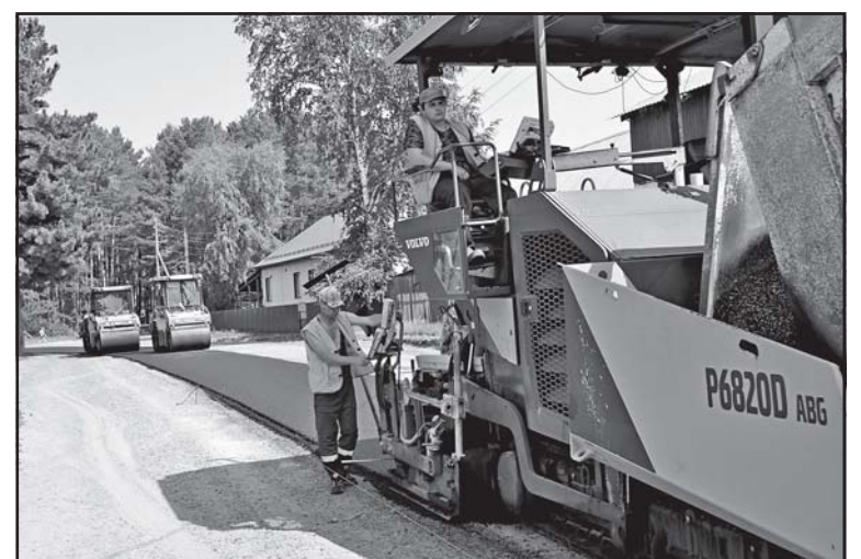
Работники ДРСУ приводят в порядок дорожное полотно по ул. Парковой
